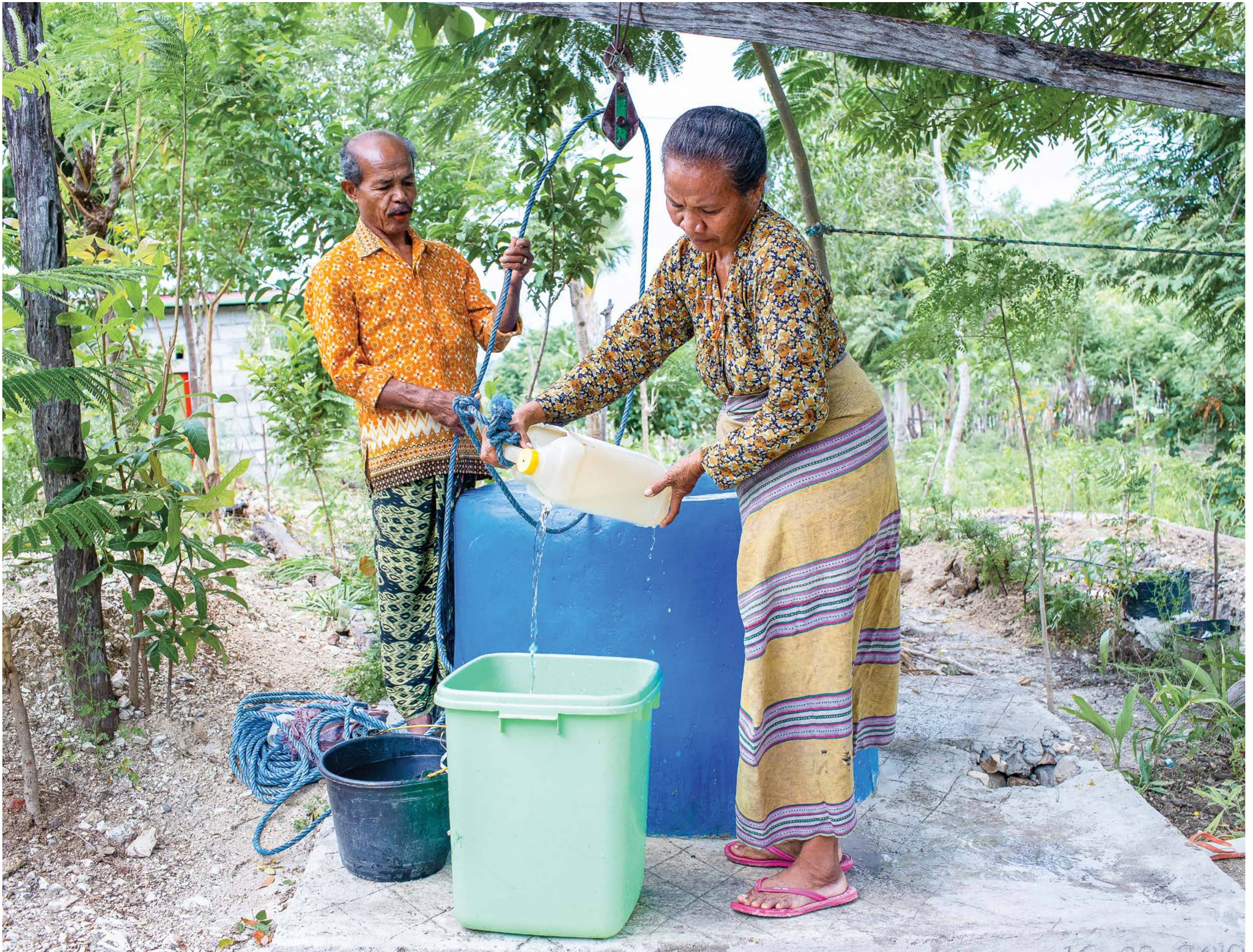
Er zijn 97 putten gebouwd in het dorp, met overheidsfinanciering voor cement, emmers, cementblokken en touwen. © CARE/Makmende Media
